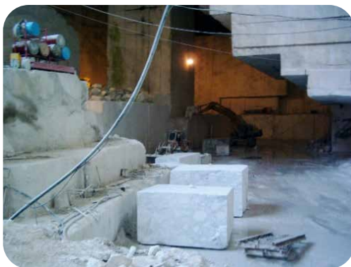
شکل ۵- نمایش کوپه‌ای تولید شده و پله‌های ایجاد شده در کارگاه زیرزمینی
