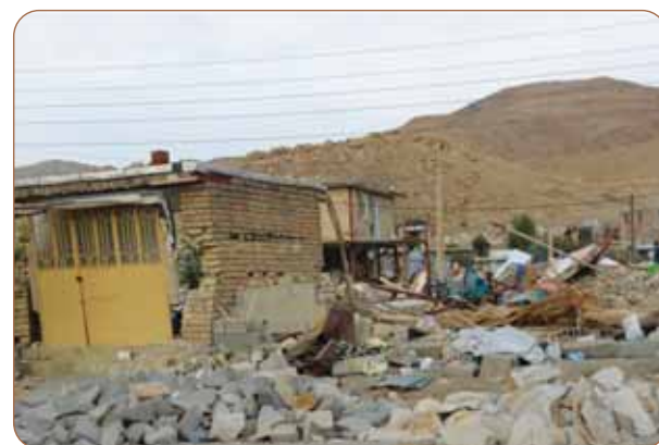
شکل ۱۰- نمایی از خرابی‌های زلزله در روستاهای تپانی و سراب ذهاب
