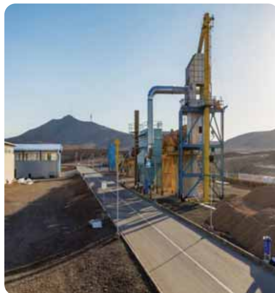
شکل ۶- خط مربوط به تکلیس دولومیت
