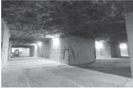
شکل ۳- نمای داخلی کارگاه استخراج روش اتاق و پایه
